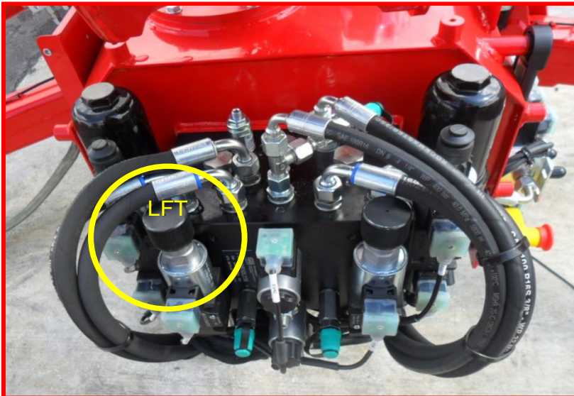
Figure 22 : vanne gauche du banc de filtres.
